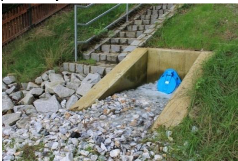
Obr. 10 Výústní objekt do rybníka, celková situace a detailní pohled na výúst s žabí klapkou (zdroj: archiv SVSMP)
