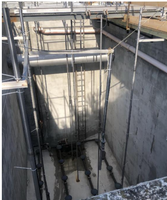
Obr. 2. Prázdna nádrž s vstrojením.
